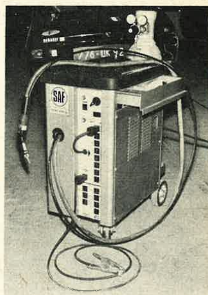
Poste de soudage sous protection gazeuse SAF mig mono bl. donnant trois possibilités de soudage :
