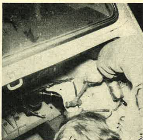
Fig. 29. — La coque étant sous tension, le pli du passage de roue droit est supprimé (photo R.T.C.).
